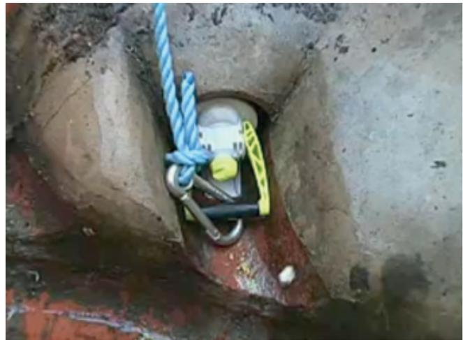
Durch die Betätigung des Exzenterverschlusses und die radiale Ausdehnung des Dichtungsgummis ist eine druckdichte und sichere Abdichtung des Rohrendes in kürzester Zeit gewährleistet.
