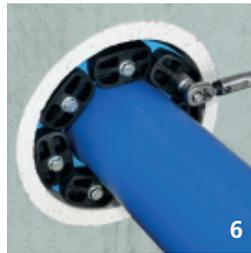
6. Jede Schraube mit ca. 4 bis 5 Umdrehungen anziehen. Diesen Vorgang **im Uhrzeigersinn** so lange wiederholen, bis das angegebene Drehmoment (siehe Tabelle) erreicht ist und der Gummi sich gleichmäßig zwischen den Druckplatten hervor wölbt.
