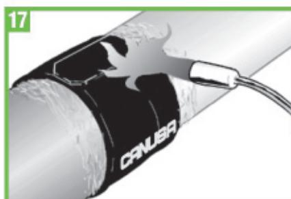
Mit einer weichen Propanflamme das separate Verschlussband abstreifen. Das Verschlussband mit dem Roller ganzflächig, senkrecht und möglichst fest auf die Schrumpfmanschette pressen. **Das Verschlussband muss am Ende ganzflächig mit der Schrumpfmanschette verbunden sein. Ggf. die Kanten des CLR-Verschlusses auch während des Schrumpfvorganges mit dem Roller andrücken.**
