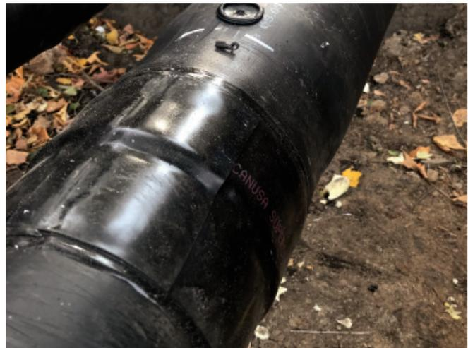
Für Superseal T und L ist das Verschlussband Typ CLR einzusetzen, das als Rollenware (100 mm und 150 mm breit und 15 m lang) verfügbar ist).
