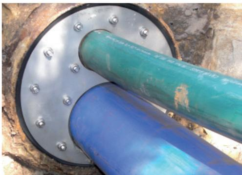
Einschubsicherung für M6 und M8
