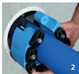
2. **Die Enden der Pressio®-Elements verbinden.** Die Schraubenköpfe müssen alle in die Richtung des Monteurs zeigen.
