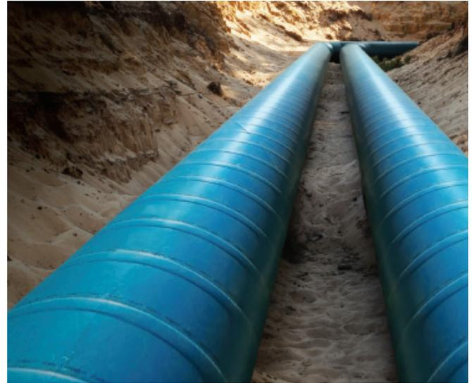
WrapidBond® ist ein **hochflexibles Korrosionsschutzband** aus einem modifizierten und verstärkten viskoelastischen Klebstoff auf einer Polyethylen-Trägerfolie. WrapidBond® wird in Rollenform geliefert und bietet einen wirksamen Korrosionsschutz, indem es eine Barriere gegen Wasser und Sauerstoff bildet. WrapidBond® ist für den Einsatz in ober- und unterirdischen Rohrleitungen und Stahlkonstruktionen geeignet.
