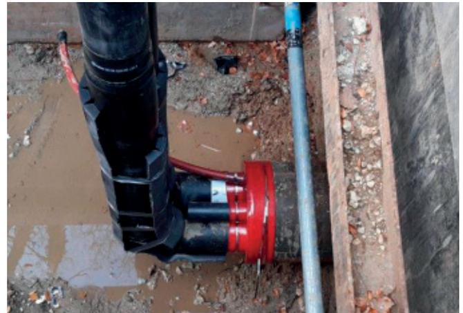
Endmanschetten Typ ASTM sind **die hochwertigste** und stabilste Variante aus hochwertigem weich PVC zur Abdichtung zwischen Schutz- und Mediumrohr. Hier besteht die Möglichkeit **mehrere Öffnungen**, für z.B. weitere Kabelschutzrohre, einzuarbeiten.
