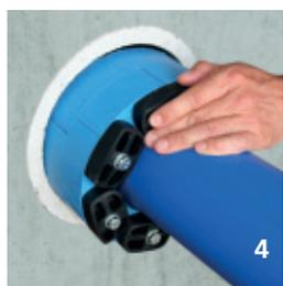
4. Die Pressio®-Elements **in den Zwischenraum schieben.** Beginnen Sie erst auf 6 Uhr Position, dann rechts und links bis zur 12 Uhr Position. Auch nach dem Einsetzen sollen die Schraubenköpfe gut zugänglich sein.
