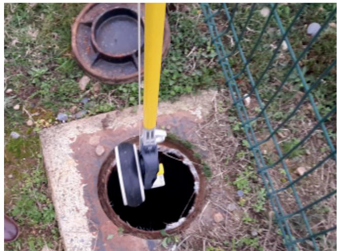
Das Lösen des Exzenterverschlusses kann - **ohne den Schacht zu betreten** - mit einem Seil oder dem **Installationswerkzeug** einfach durch nach oben ziehen erfolgen.
