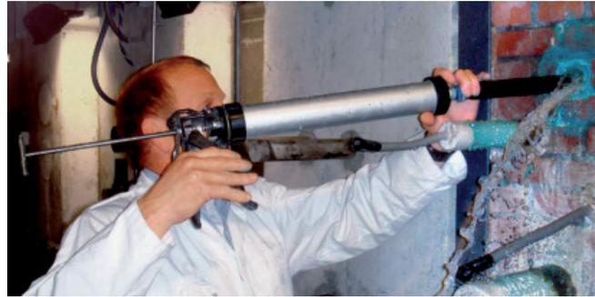
Wasserdichte Abdichtungsmasse für Mauerdurchführungen von Rohren und Kabeln
