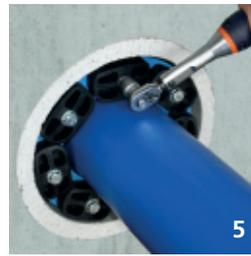
5. Die Schrauben auf 12 Uhr beginnend mit einem **Drehmomentschlüssel anziehen**. Kein Anziehen mit Schlagschrauben!
