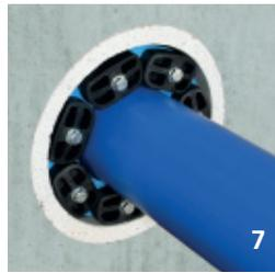
7. Nach ca. 2 Stunden die Schrauben nochmals mit dem angegebenen Drehmoment **nachziehen**. Abhängig von den äußeren Bedingungen (Temperaturen <10°C, großer Ringraum, usw.) diesen Vorgang mehrmals wiederholen. Dies ist besonders ab IL 500 und größer zu beachten.
