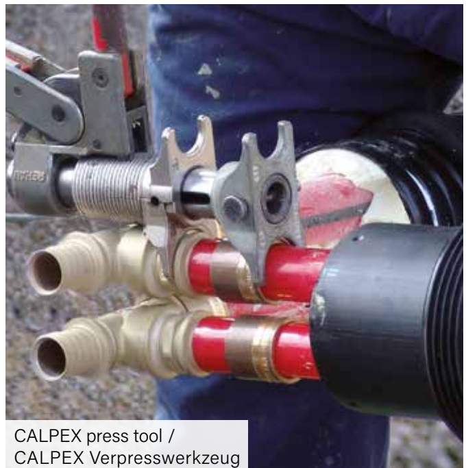
Spectacular pipe installation with ploughing method in DE-Berlin / Spektakuläre Leitungsverlegung via Pflugverfahren in DE-Berlin
