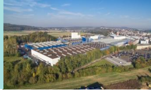
Heizkessel bodenstehend Lollar, Deutschland
