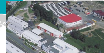
Heizkessel bodenstehend Krnov, Tschechien
