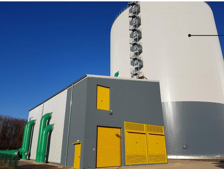
Bilfinger erhielt als Generalunternehmer von den Stadtwerken Duisburg AG den Auftrag über die Planung, Lieferung, schlüsselfertige Errichtung und Inbetriebnahme eines Zweizonen-Fernwärmespeichers inklusive Pumpenhaus zur Speicherung und Verteilung von Fernwärme.
